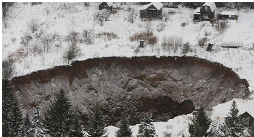
Рисунок 3 – Провал над пустотами шахтных выработок
